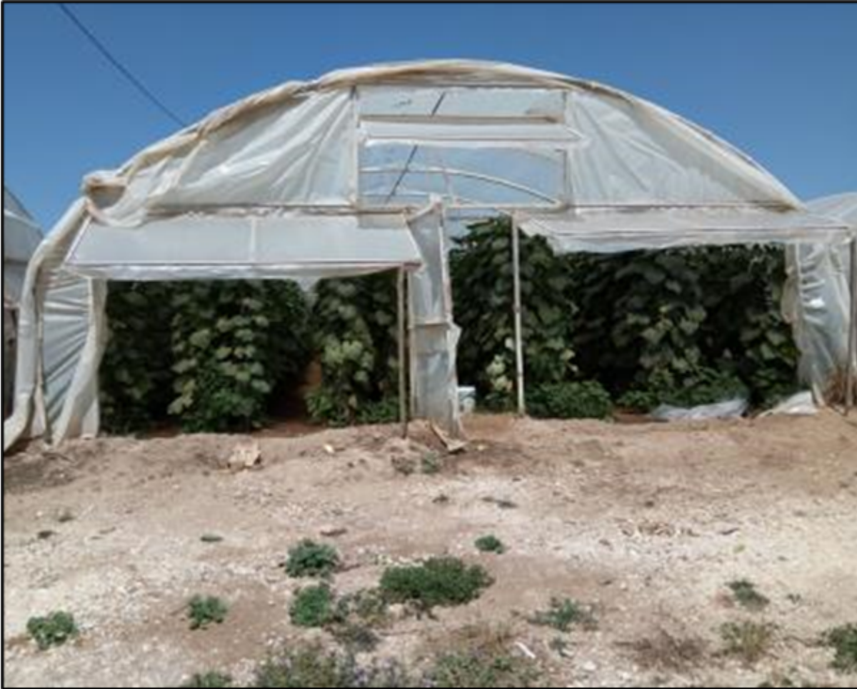
Ubicación 1. Mirada general de la estructura del túnel y el cultivo poco después del transplate.
